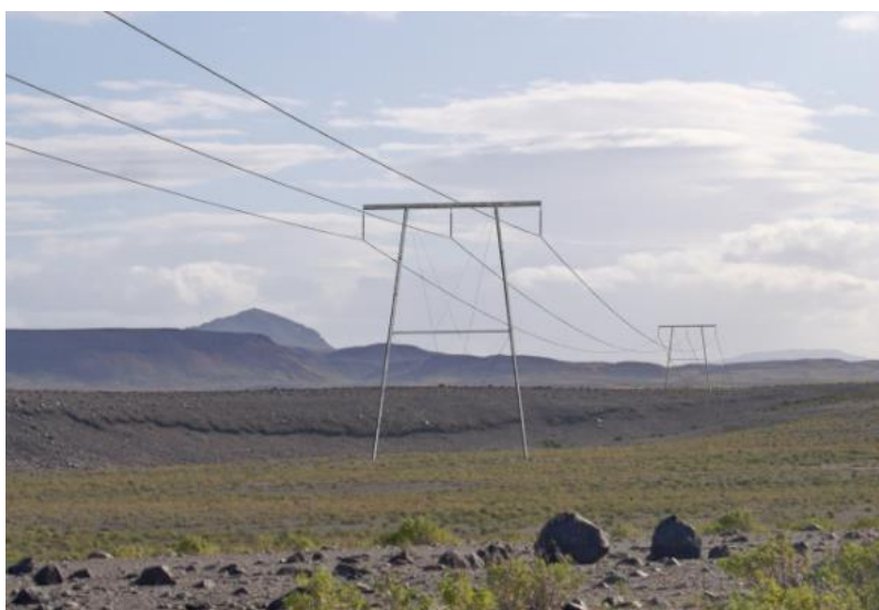
Mynd 2 Burðarmöstur í TR1 með og án jarðvírseyra á efri hluta myndar.
