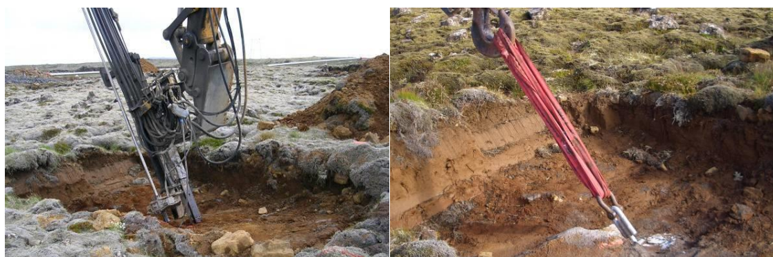
Mynd 5 Dæmigerð mynd þar sem borað er fyrir bergbolta og til hægri er mynd af átaksprófun boltans.
